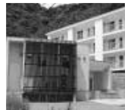
完成した生徒寮(右側)手前が食堂棟
