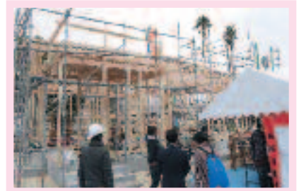
建設中の「ENEハウス」
