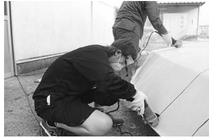
FRP船の解体作業（船の構造が学べます）
