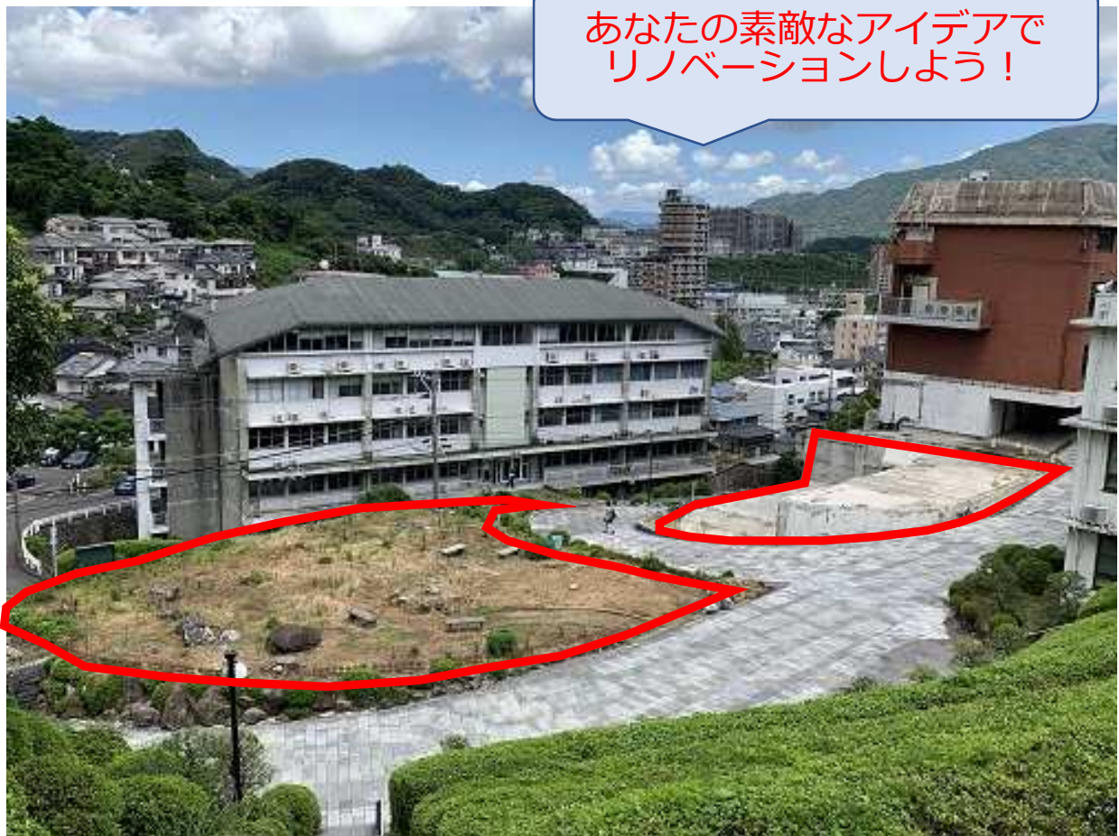
現地写真（左：正門横広場、右：5号館A棟跡地）
