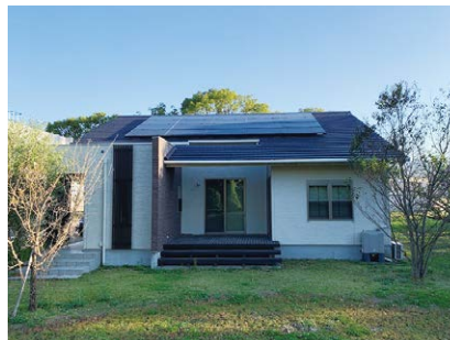
実証実験用スマートハウス Smart-house for experiments
