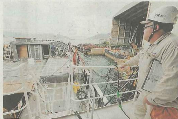
急ピッチで工事が進むメロ船(左側)
